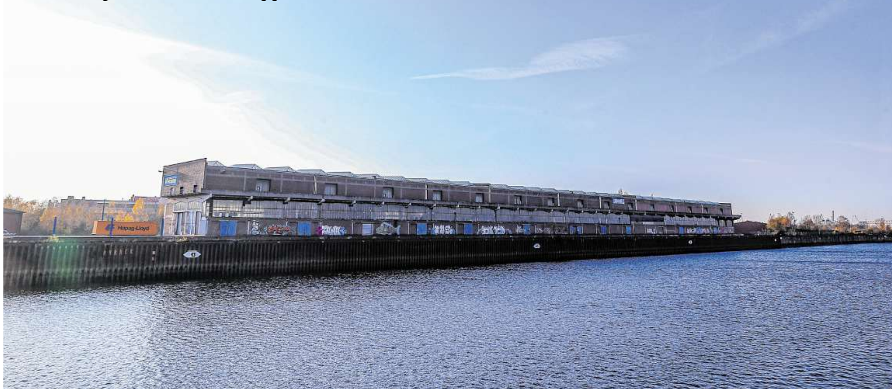
Der Schuppen 6 am Europahafen in der Überseestadt. Er ist rund 300 Meter lang und etwa 40 Meter breit.
