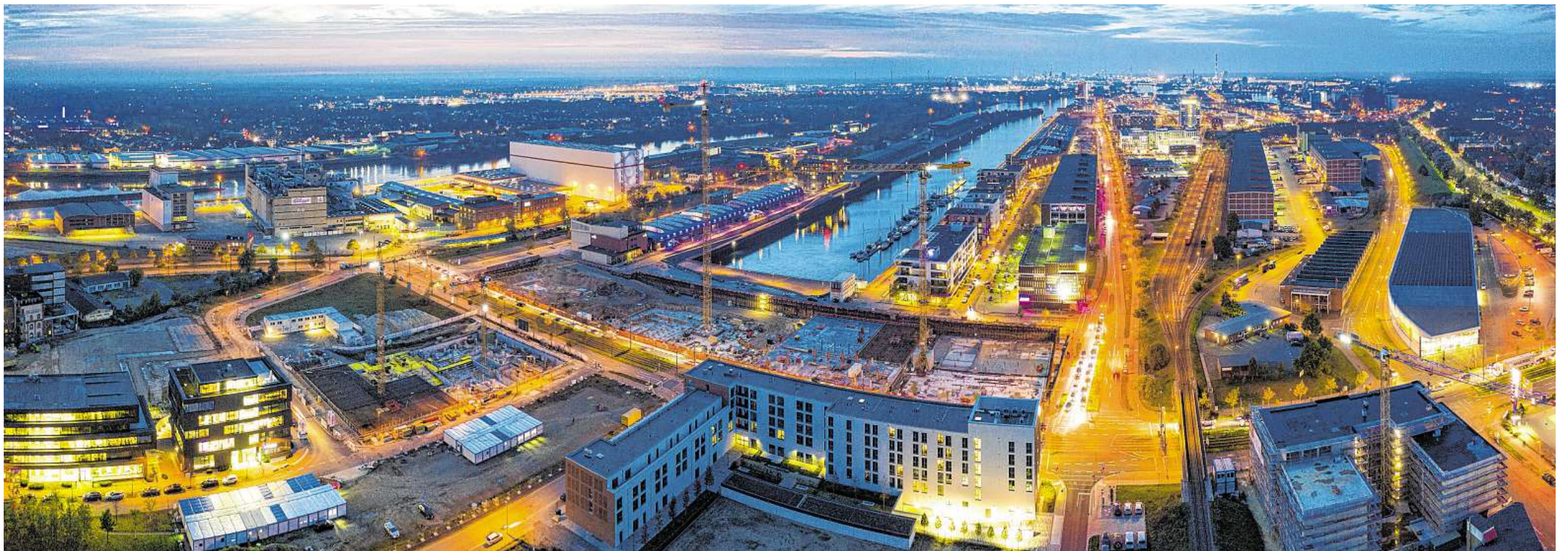
Die Überseestadt im Abendlicht. Am Kopfende des Europahafens baut der Bremer Unternehmer Kurt Zech gerade ein großes Gebäudeensemble.
