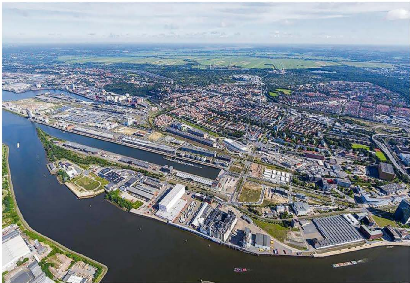
Zwischen Hafen und Weser: Die Überseeinsel soll Platz für Wohnungen, Büros, Gastronomie und Logistik bieten. Foto WFB Studio B
